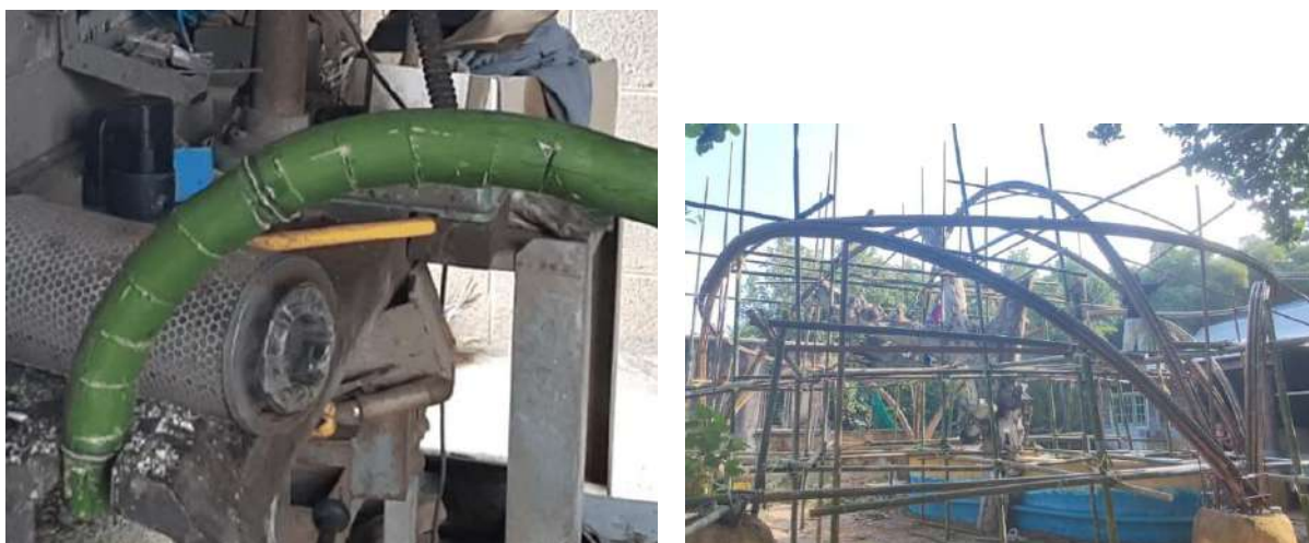
Figure 10 : Technique de fentes transversales pour courber le bambou
