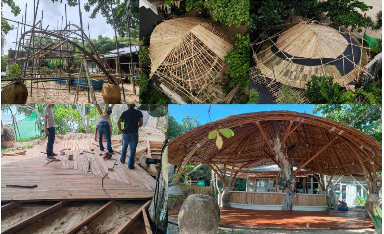
Figure 3 : Différentes étapes de construction du pavillon
