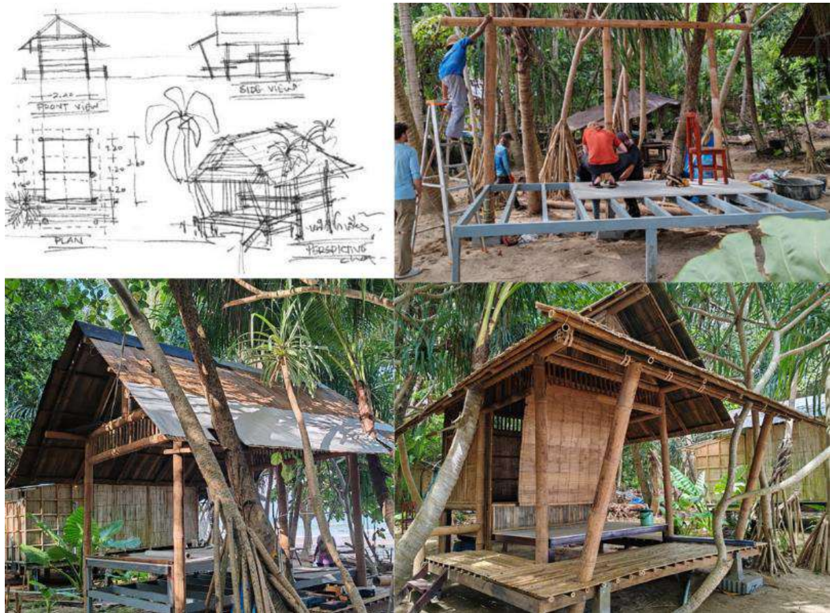
Figure 4 : Différentes étapes de construction de la cabane
