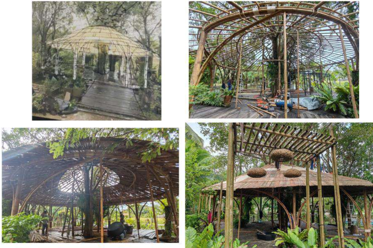
Figure 5 : Différentes étapes de construction du pavillon
